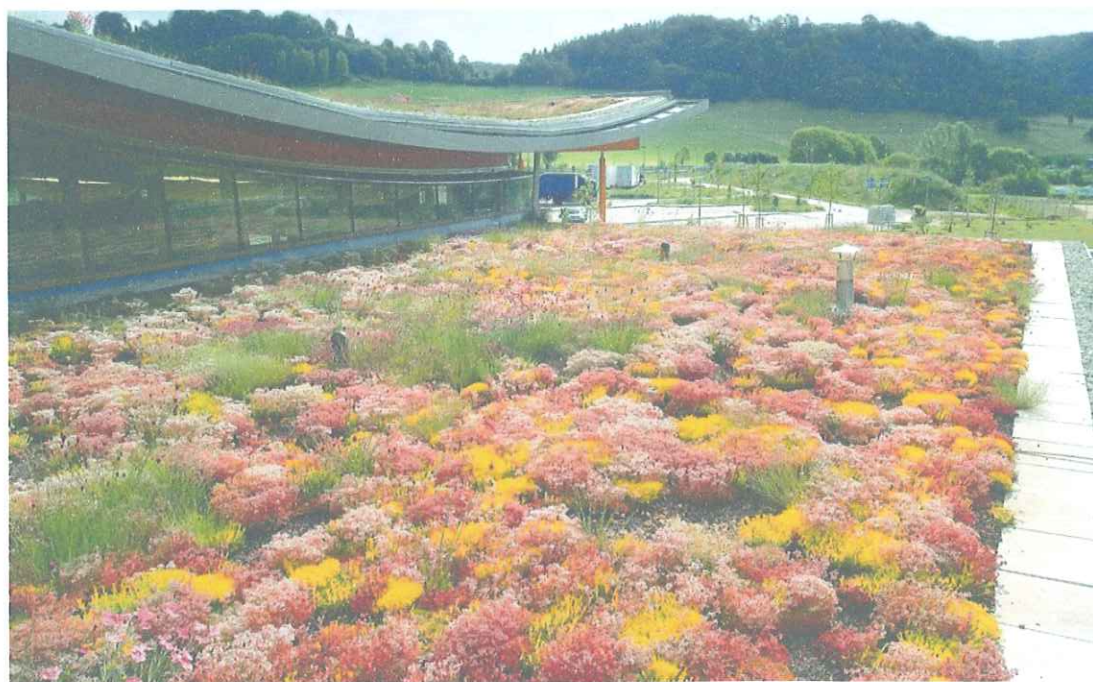
Ryc. 2 Przykład dachu ekstensywnego
